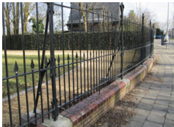
gietijzeren hek op bakstenen plint (Marepark)
